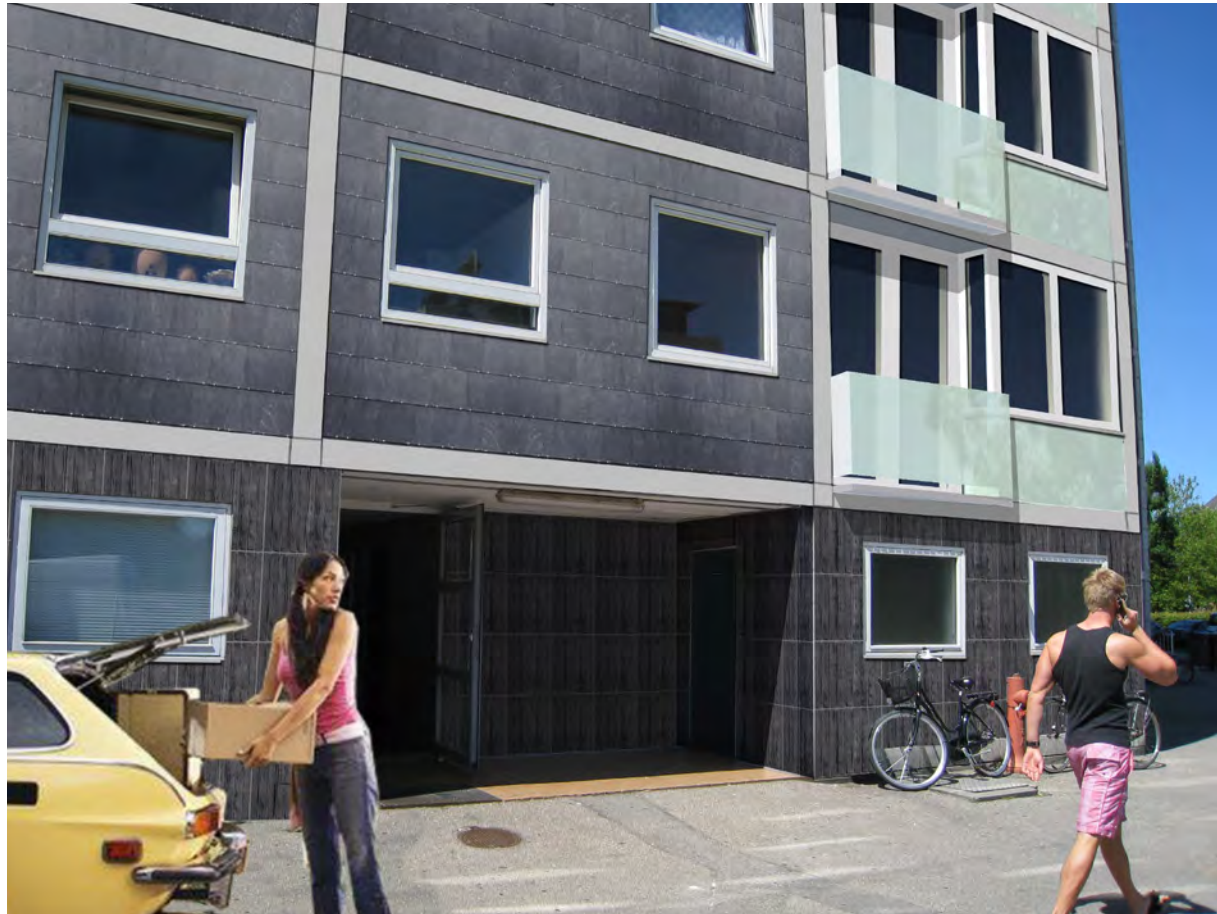
Eksempel på nyt facadeudtryk med skiferbeklædning, glas ved stuepartier samt smukke og robuste blå-dæmpede tegl i stueetagen. III.: JJW Arkitekter.
