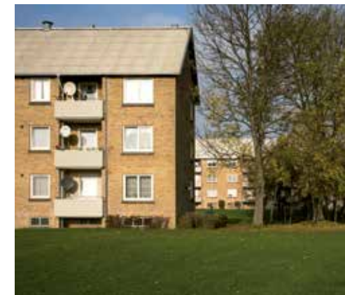
Facade (kilde: Energimærkingen fra fsb).
