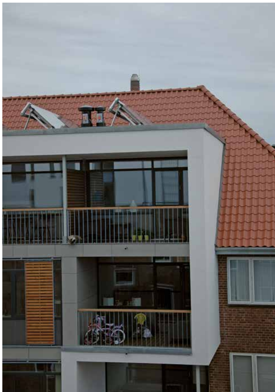
Da Ringgårdens afdeling 1 i Aarhus fra 1941 skulle renoveres, blev den vurderet bevaringsværdig, og der blev gjort omfattende bestræbelser på at bevare den oprindelige arkitektur. Beslutningen om at skabe ældreegnede boliger med elevatoradgang førte imidlertid til så drastiske forandringer, at bebyggelsen blev ukendelig.
