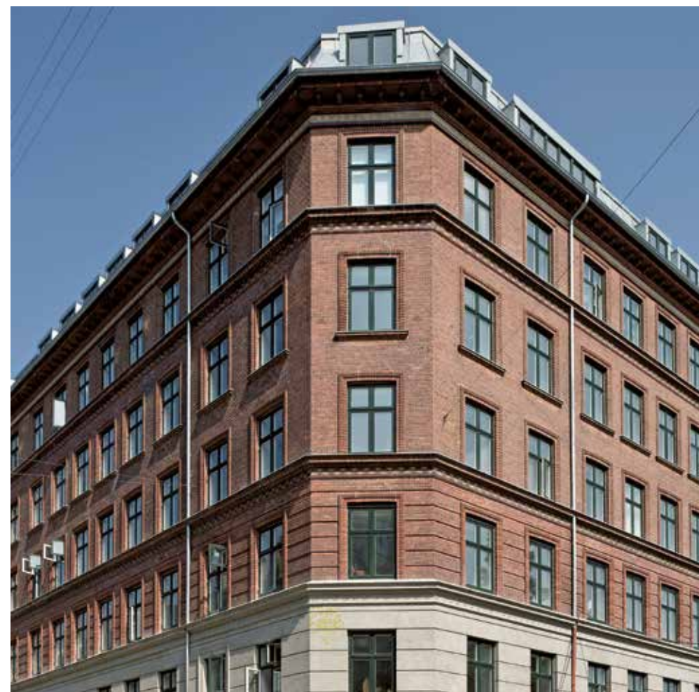
Indvendig efterisolering, billede fra Ryesgade 30. Ejendommens facade fra 1896 fremstår uændret efter energirenoveringen, og de nye vinduer er holdt i samme dimensioner som de originale.
