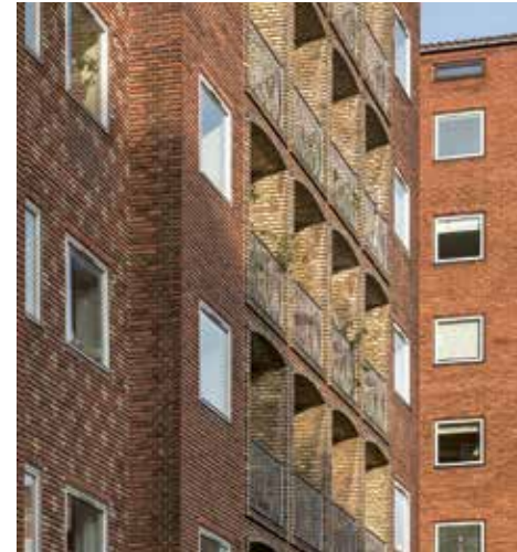
Dronningegården, København, arkitekterne Kay Fisker, C.F. Møller og Svann Eske Kristensen. Et eksempel på murværkets fladevirkninger, mønstermurværk i to farver sten og fremhævnning af enkelte detaljer med blandt andet murede stik over åbninger i muren.
