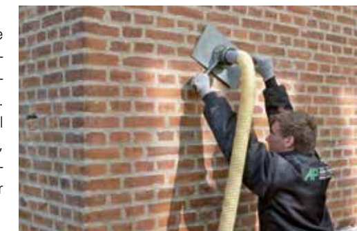
Indblæsning af hulmursisolering, der foregår ved at udtage sten i ydermuren med 1½-2 meters mellemrum og lukke hullerne med de samme sten, som er blevet udtaget.
