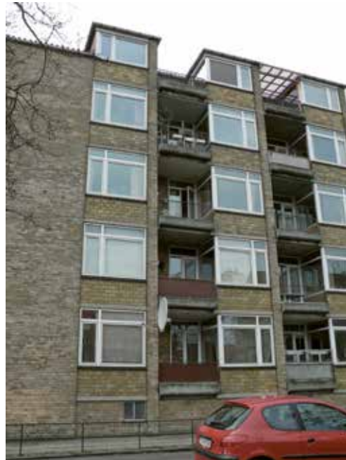
Bispeparken før renoveringen.
