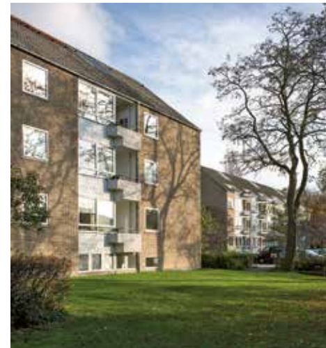
Bredalsparken, Hvidovre, arkitekt Svann Eske Kristensen. Et eksempel på en delvist indeliggende altan, der griber fat i karnappen med det reliefudsmykkede betonværn og danner et samlet element i kontrast til murværket.
