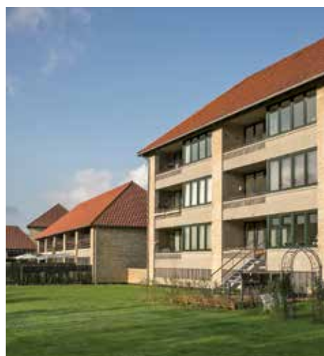
Nærumvænge, Nærum, arkitekt Palle Suenson. Et eksempel på dominerende valmtage i rød tegl, der afslutter bygningen med et markant og roligt element, som også bliver en vigtig del af bebyggelsens profil i landskabet.
