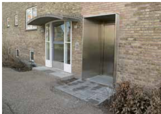
For at skabe bedre tilgængelighed og ældreegnede boliger ses her, hvordan et indgangsparti er ændret med tilføjelse af elevatoradgang til højre for hovedindgangen.
