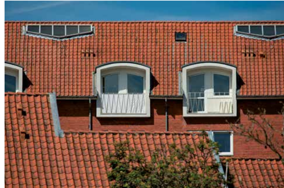
De hvidmalede altaner i beton er et meget karakteristisk kendetegn for perioden, her som effektivt element i overgangen mellem den murede facade og tegltaget.
