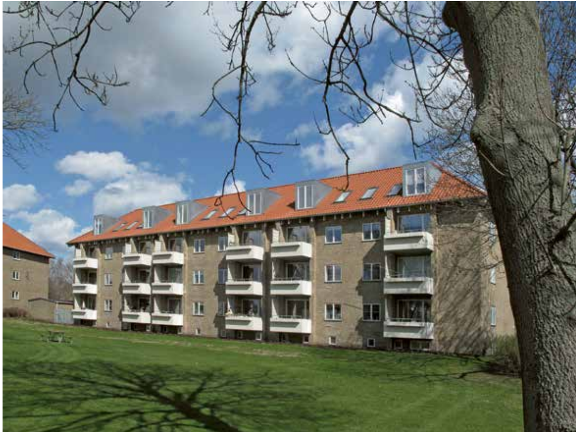
De tidstypiske facader med gule mursten og hvide altaner står uberørte efter renoveringen, hvor nye tagboliger blev etableret.
