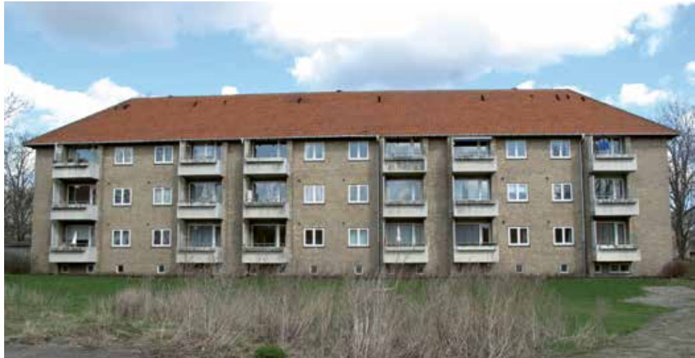
Fortunbyen før renovering
