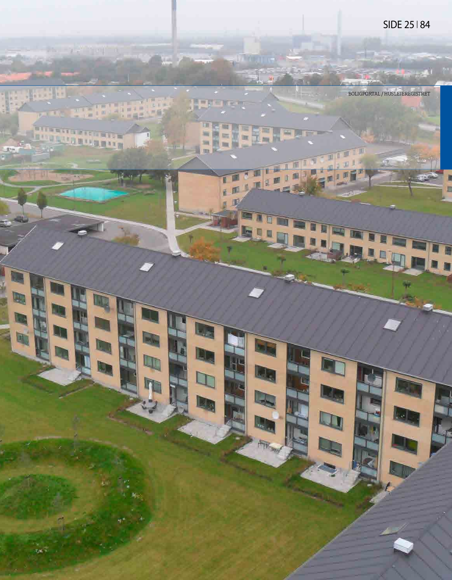
Lejerbo Kolding, afd. Munkebo Foto: Jens Rudolph
