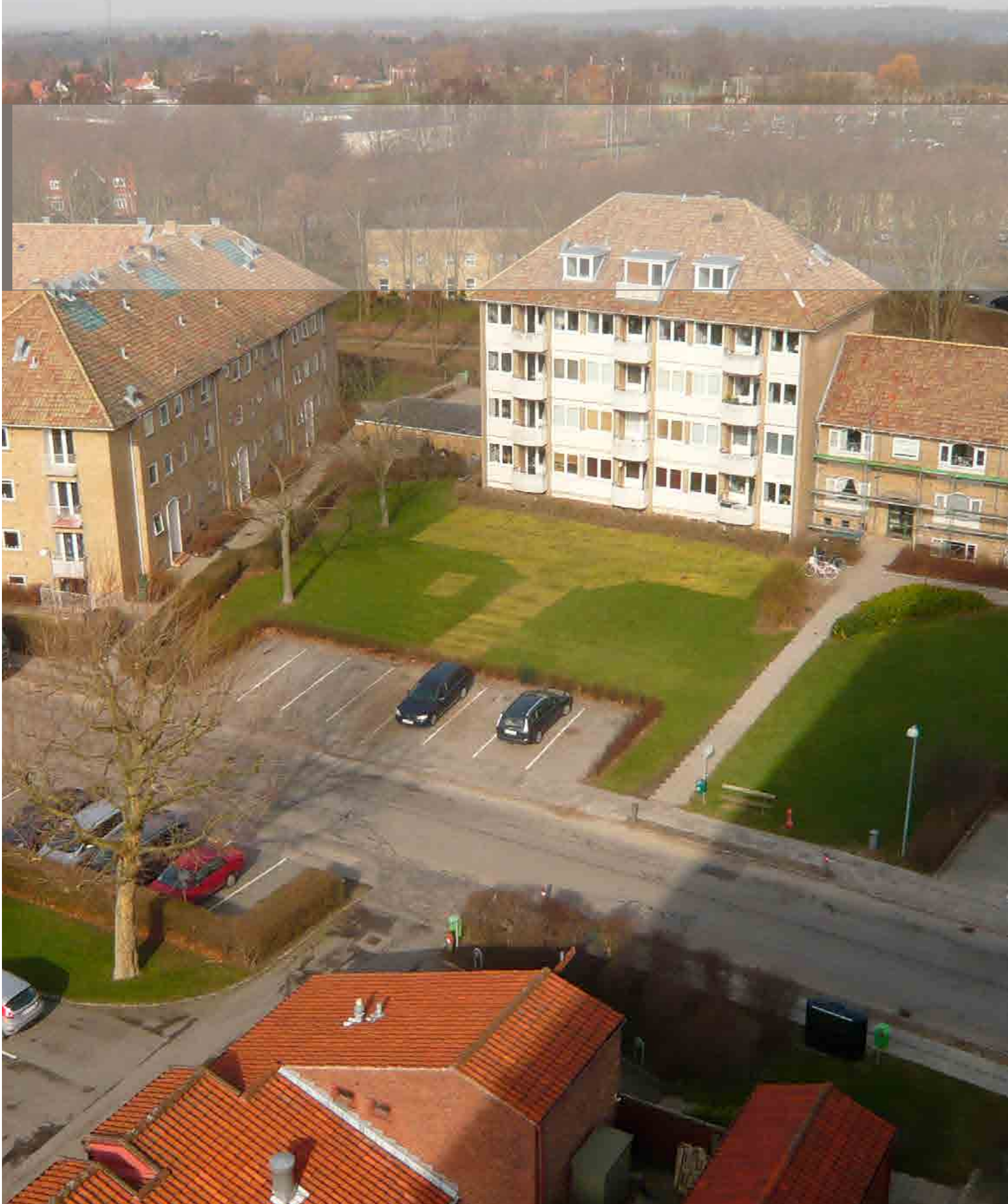
Carlshøj, afd. 11 Foto: Landsbyggefonden
