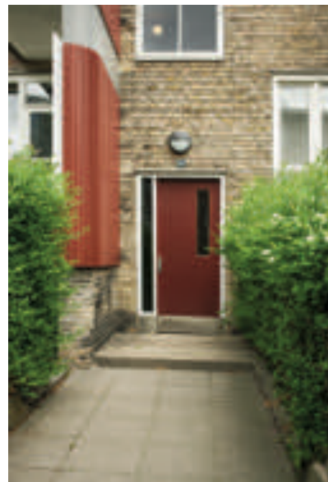
Yderdørene er af nyere dato, rødmaledede og med hvide sidepartier. Der er et enkelt trappetrin støbt i beton op til døren.
