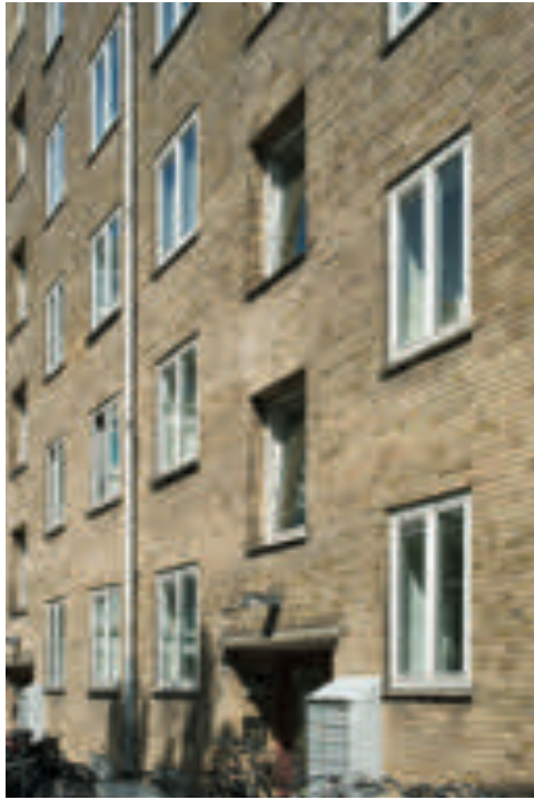
Facaderne uden altaner er helt glatte, hvor alle vinduer med undtagelse af dem ved trappeopgangene næsten ligger i facadeflugten. De dybereliggende vinduer giver facaden en fin reliefvirkning.
