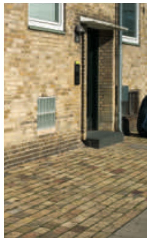
Stierne foran husene er udført med en belægning af gule mursten, som skaber sammenhæng mellem hus og terræn.
