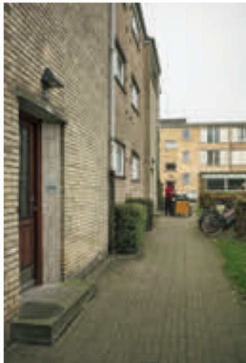
De gule murflader bliver brudt af de tilbagetrukne døre, som giver en fin reliefvirkning på facaden.
