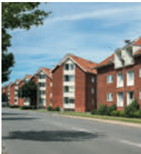
Facaderne er karakteriseret ved et spil mellem de hvide betonelementers lodrette markeringer og de røde murede flader.
