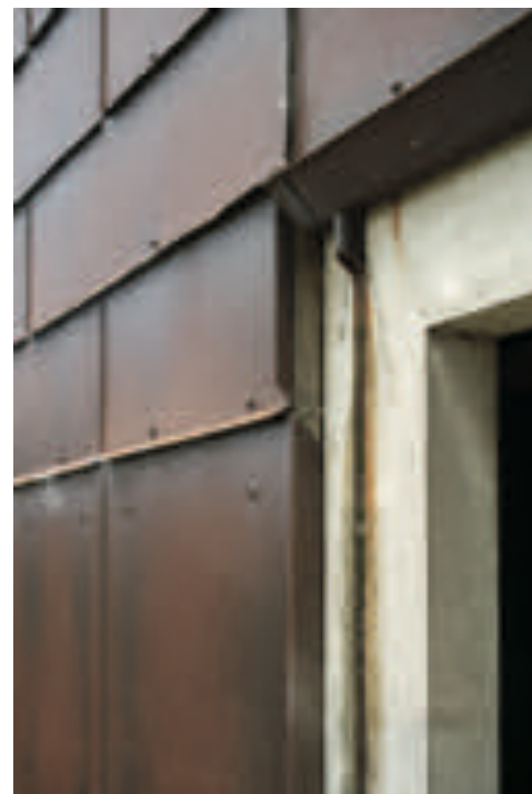
Facaderne er beklædt med cortenstål.
