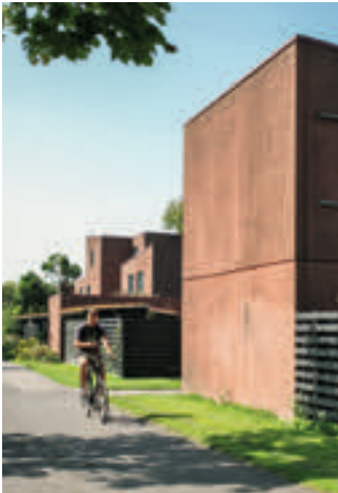
Husene er opført i indfarvede betonelementer i røde, brune og blå farver.
