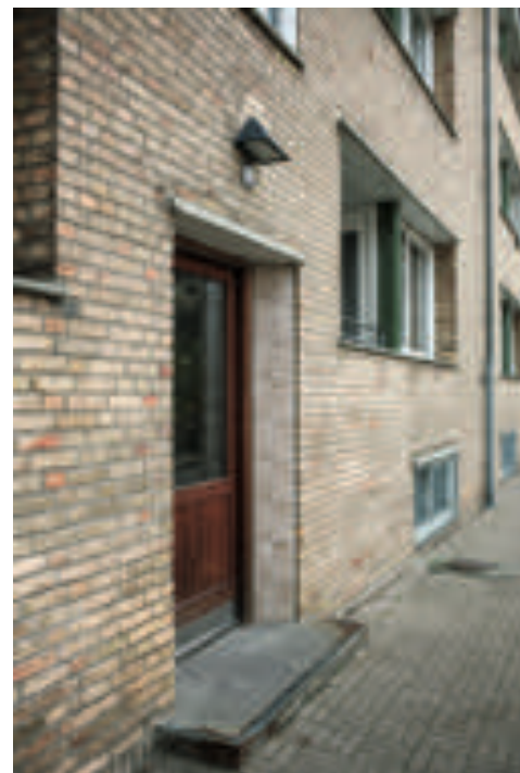
Mange af de ældre lakerede indgangsdøre af træ med et vinduesfelt er blevet bevaret.
