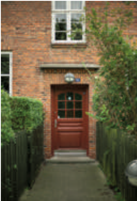
Vinduer og terrassedøre er i træ og hvidmalede. Yderdørene er malede i forskellige farver, her en rødmalet. Nogle af dørene er originale og med kitfalsede sprosser, mens mange desværre er blevet udskiftet.
