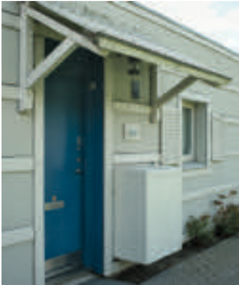
Gårdhavehusenes indgang har en hoveddør med betontrappetrin, og over døren en trækonstruktion, som bærer et skrånende halvtag i bølgeeternitplader. Ved siden af hoveddøren ses boligens eneste vindue mod de offentlige arealer.
