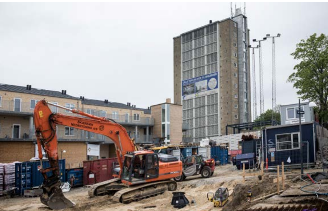
Privat nybyggeri og Samvirkende Boligselskaber afd. 1 Tingbjerg
