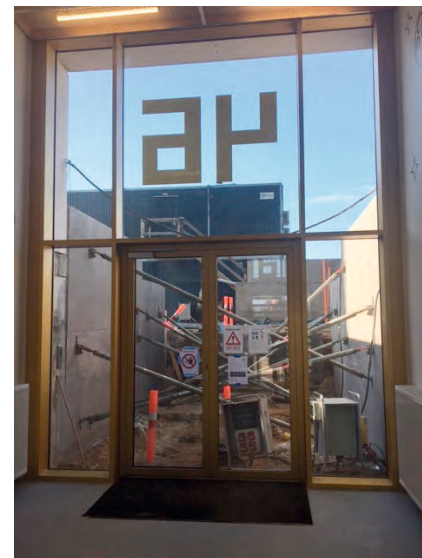
FIGUR 44. I Gellerupparkens Blok 4 har opgangene fået dobbelthøje, gennemlyste indgangspartier for at fremme trykgheden. For mange beboere er generne ved omdannelsen dog også en væsentlig kilde til utrykghed: det gælder både de konkrete byggeplads gener, men især også risikoen for ikke selv at kunne blive boende.
