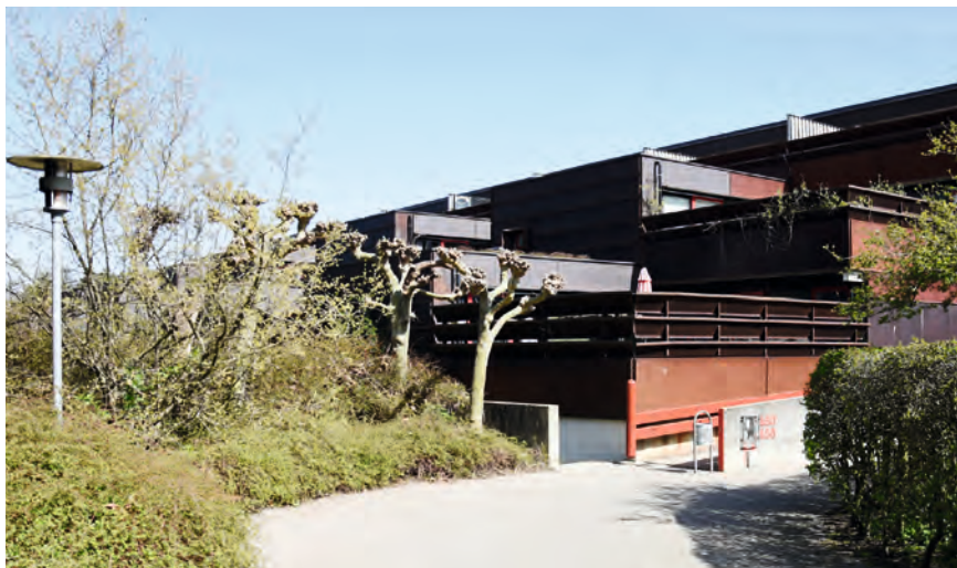
FIGUR 85. PCB-renoveringen har ikke ændret væsentligt på Farum Midtpunkts karakteristiske terrassehuse.
