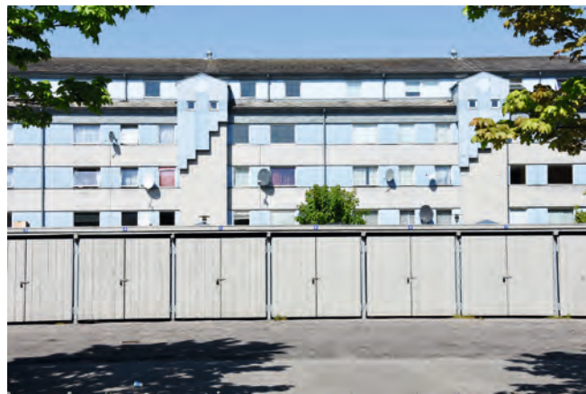
FIGUR 47. Boligblokkene i Dianavænget har de udfordringer, der er typiske for montagebyggeri fra efterkrigstiden. Den renovering, der i 1990'erne er blevet gennemført på nogen af blokkene (th.) er også på uheldig vis typisk for datidens indsats.
