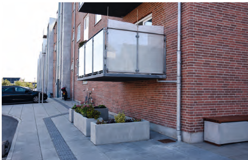
FIGUR 75. En altan er placeret i øjenhøjde tæt ved et gadehjørne. Plantekasser er opstillet for at sikre, at fodgængere ikke kommer til skade.
