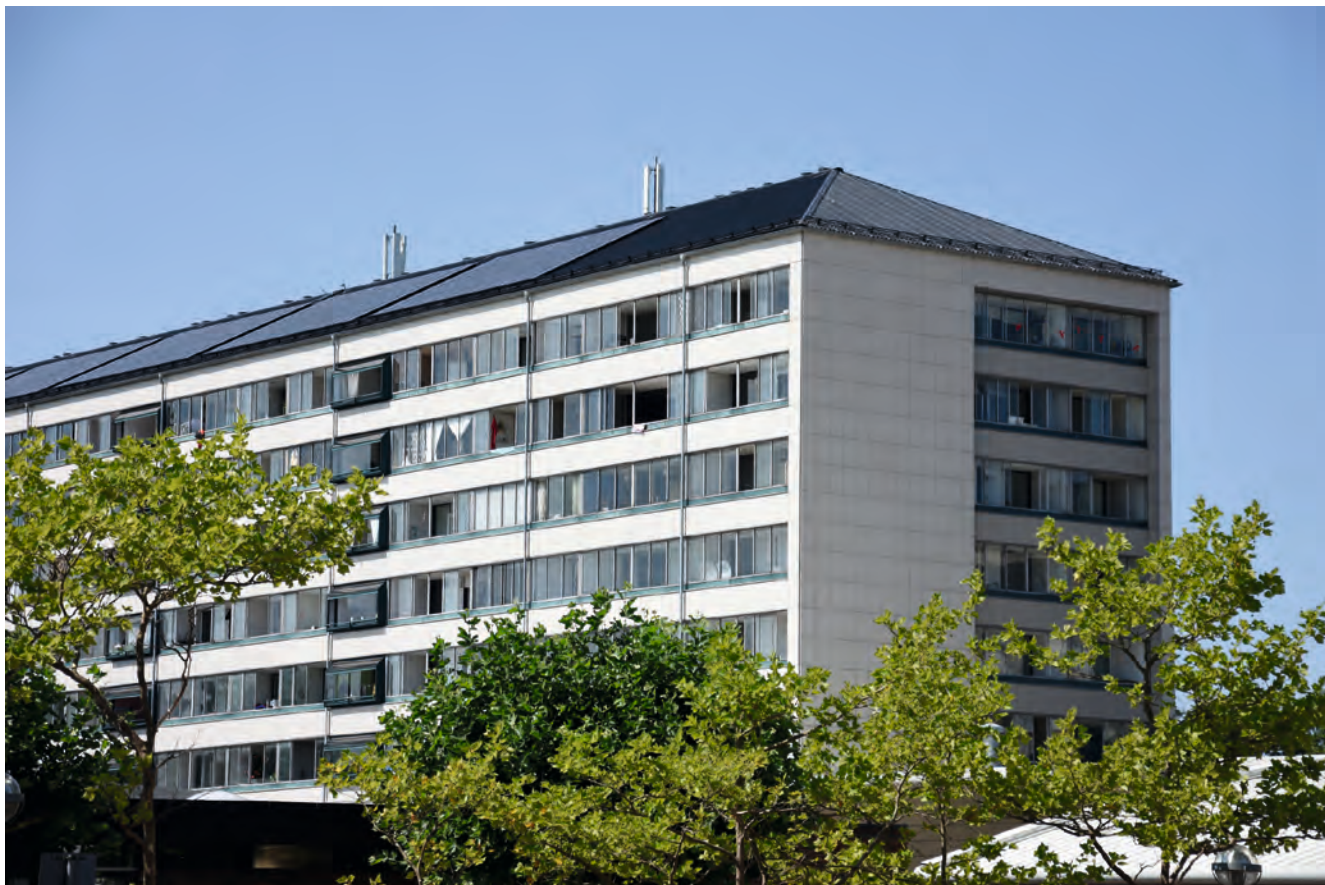
FIGUR 4. I Grantofte har vinduesudskiftninger og efterisolering af facaderne ført til store forbedringer i boligernes komfort. Desværre kan det forventes, at beboerne snart skal gennem en ny renovering, da faldstammerne er nedslidte.
