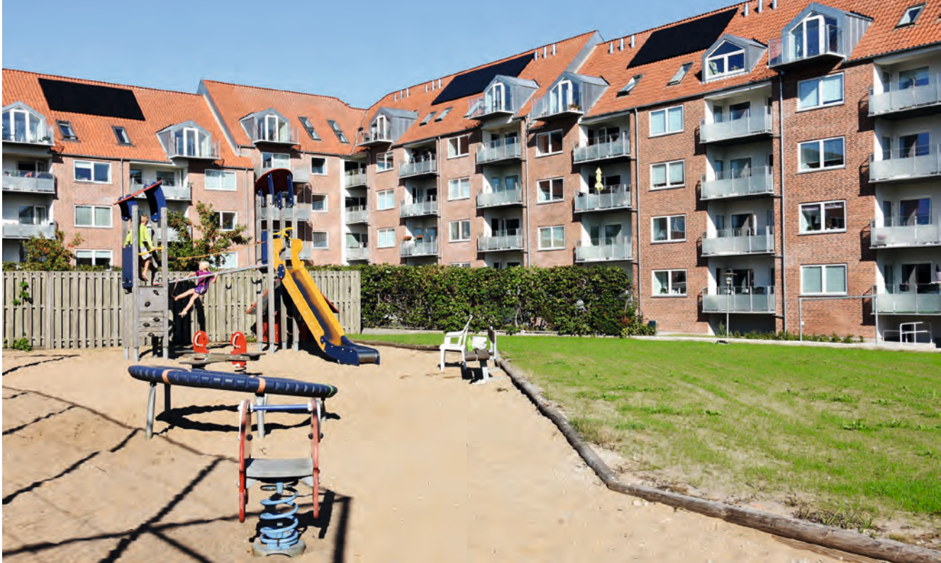
FIGUR 72. Den renoverede bebyggelse set fra det centrale gårdrum – her med legepladsen i forgrunden.
