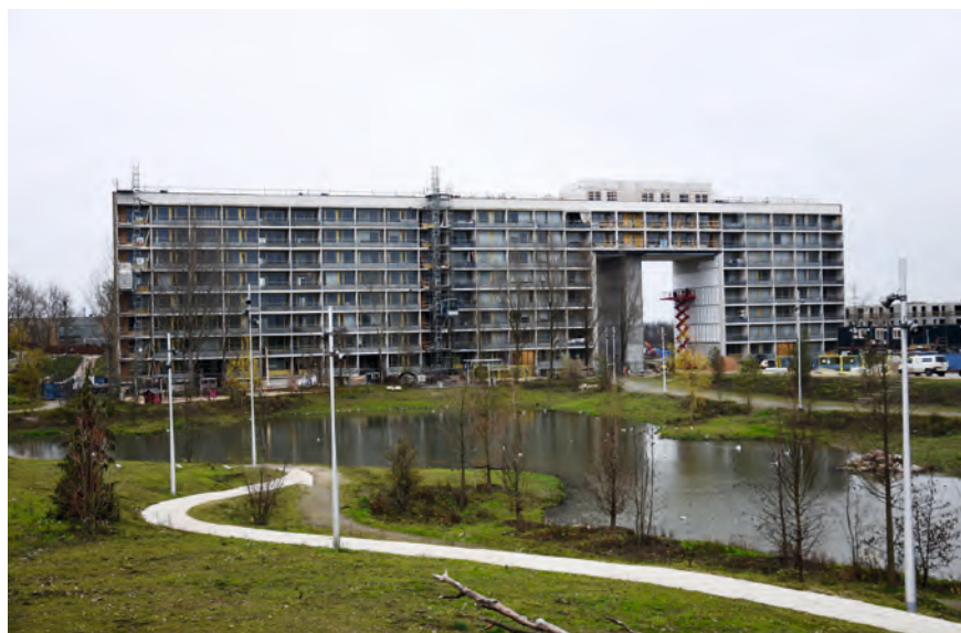
FIGUR 54. Blok 4 set fra vest, med en ny bypark i forgrunden.
