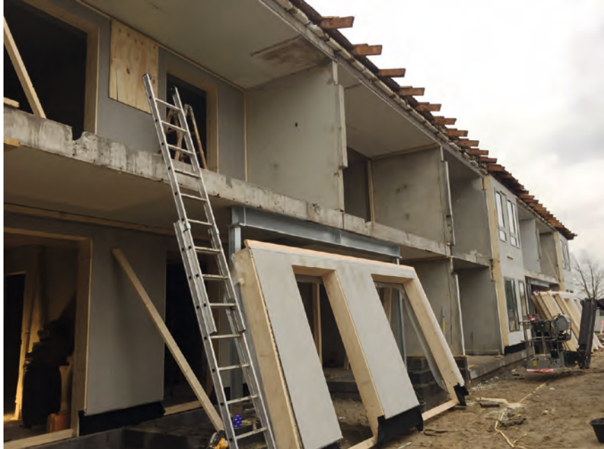
FIGUR 64. Renoveringen af boligblokkene er sket med præfabrikerede facadeelementer.
