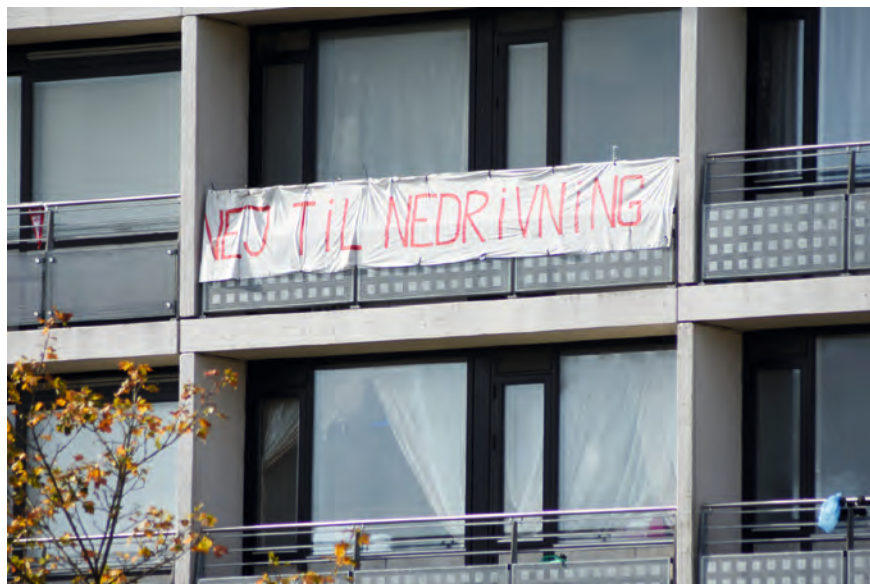
FIGUR 59. Der har gennem årene været utilfredshed med de bystrategiske omdannelser af Gellerupparken, mens renoveringen af de enkelte boligblokke er mere velkommen. Der er dog visse ting ved renoveringen, som beboerne ikke er tilfredse med.
