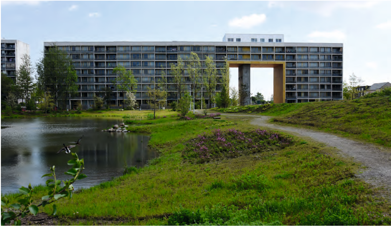
FIGUR 53. Blok 4 set fra vest, med en ny bypark i forgrunden.
