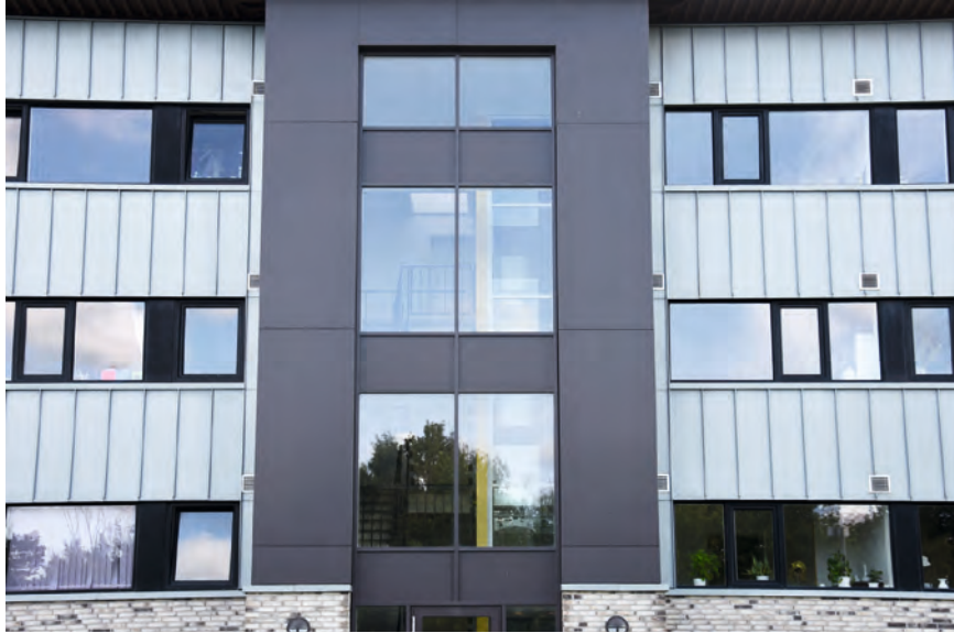
FIGUR 29. På facaderne på boligblokken på Frueløkke mødes forskellige typer af metalbeklædninger omkring indgangspartierne.
