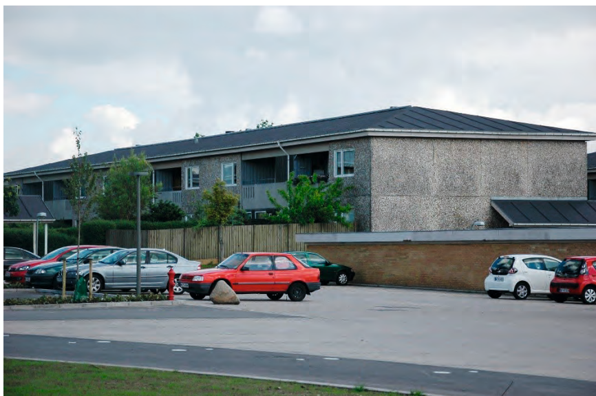
FIGUR 63. Ravnkildevejs boligblokke før gennemført renovering.
