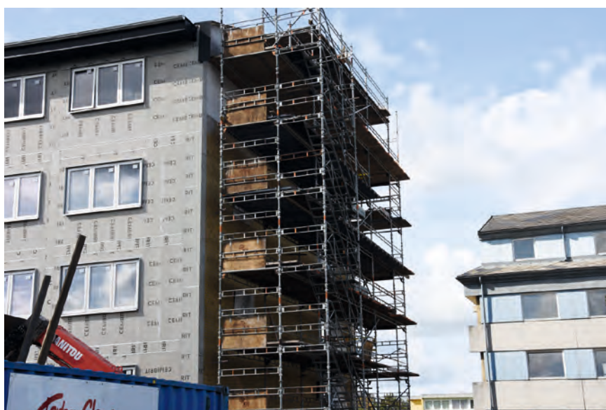
FIGUR 48. Igangværende renovering i efteråret 2019.
