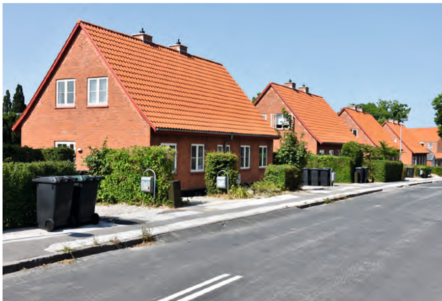
FIGUR 77. Boligselskabet Sjællands afdeling 403 består af 12 dobbelthuse i den sydøstlige del af Holbæk. Alle boliger har privat have på husets bagside.
