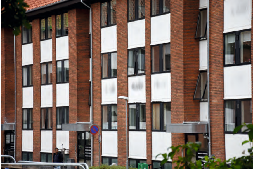
FIGUR 109. Ankomstfacade efter gennemført renovering.
