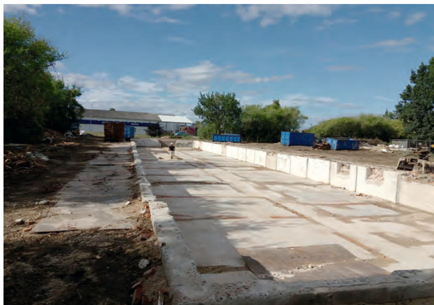
FIGUR 99. Margrethevængets boligblokke har været revet helt ned til soklen, og ovenpå soklerne er der opført nye rækkehuse. Foto: Peter Køhlert Olesen.
