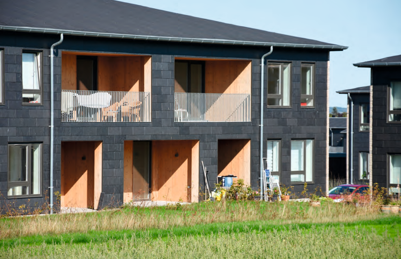
FIGUR 13. På Ravnkildevej er alle boligblokkenes etværelses lejligheder blevet nedlagt i forbindelse med renoveringen. Det skyldes ikke problemer med at få dem udlejet.
