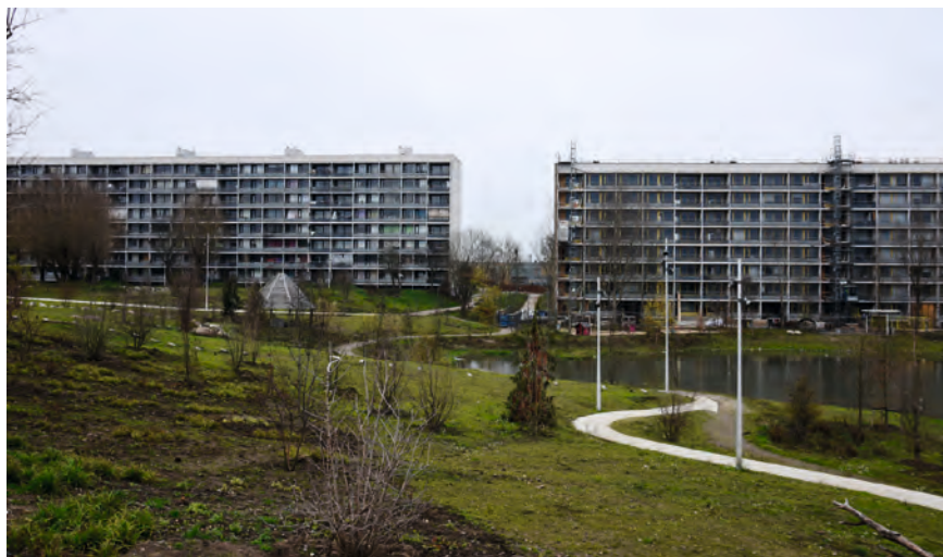
FIGUR 22. Blok 4 til højre på billedet er blevet renoveret, mens boligblokken til venstre fortsat fremtræder i oprindelig form. Det er svært at bevare alle de oprindelige kvaliteter, og det er fx vigtigt at huske, at tilføjelser på boligblokkenes tagflader er en del af det arkitektoniske udtryk. I store træk har Blok 4 dog bevaret sit arkitektoniske udtryk.
