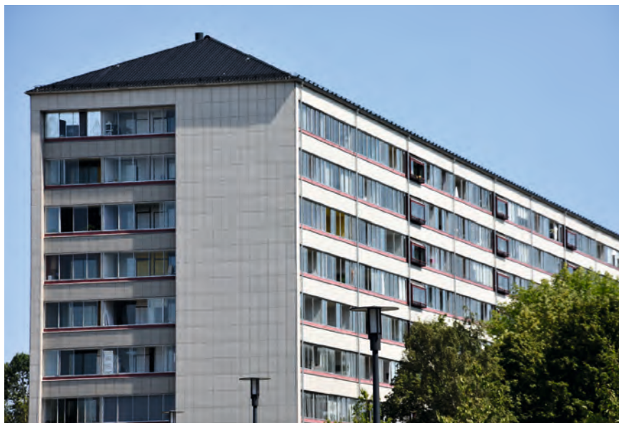
FIGUR 88. Boligblokkenes facader er blevet efterisoleret og beklædt med keramiske plader, og øverst er der kommet nye tage med hældning. Det vigtige møde mellem facader og tagflader er enkelt og veludført.
