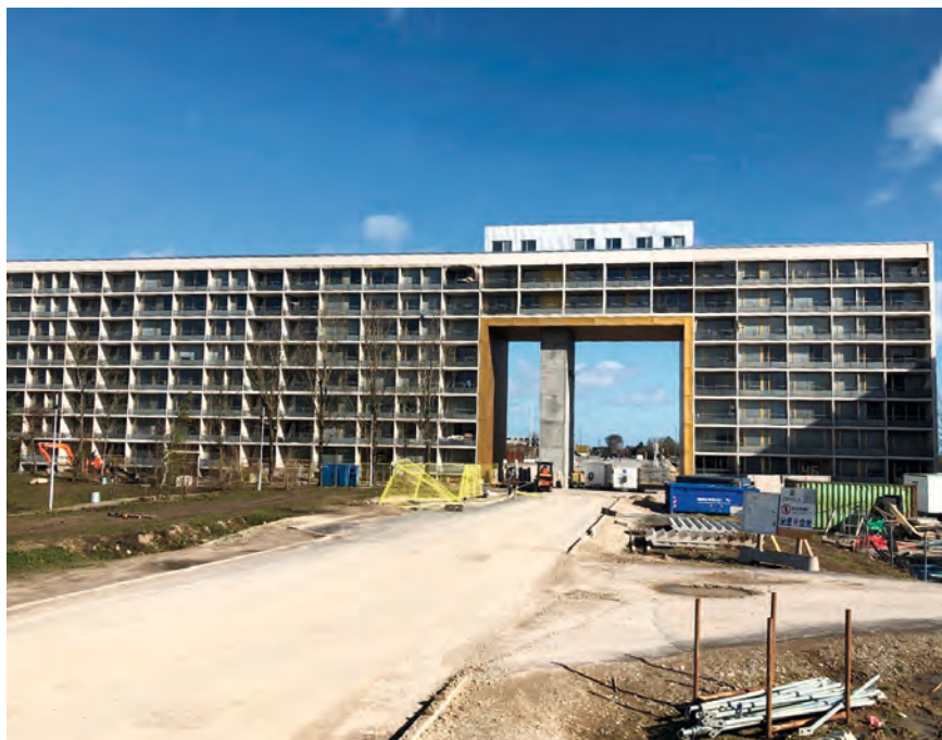
FIGUR 23. Renoveringsopgaven er en balancegang, hvor overordnede fortællinger og bærende arkitektoniske kvaliteter bevares, samtidig med at boligområdet omdannes til noget nyt og anderledes. Portrummet i Blok 4 i Gellerupparken er en markant fornyelse, der har symbolsk betydning. Valget af, at lade Blok 4 og Blok 7 være genstand for pilotprojekter var i sig selv strategisk begrundet, da de begge har en meget synlig placering. Foto: Rene Qvist Jensen.
