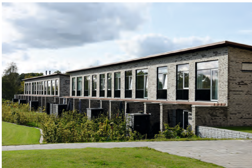
FIGUR 92. Tre boligblokke på Frueløkke er blevet nedskaleret til mindre rækkehuse. I forbindelse med nedskaleringen er to af boligblokkene blevet delt over på midten, og derved har de nye rækkehuse fået en volumen, der passer fint til deres højde.
