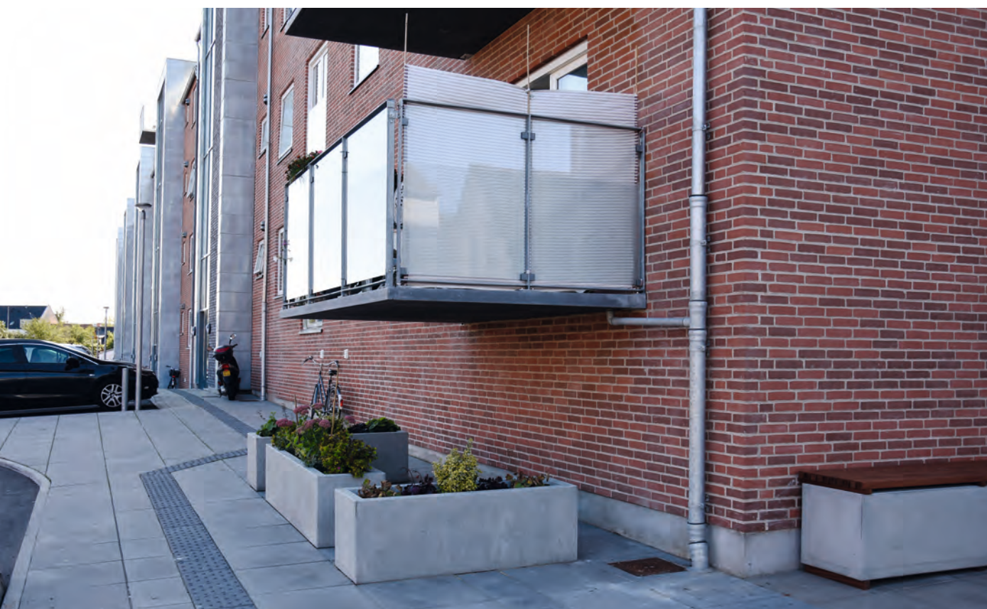
FIGUR 7. Nye altaner på Bakkegården i Frederikshavn har generelt ført til øget boligkvalitet, men en af stueetagerens altaner er meget uheldigt placeret.
