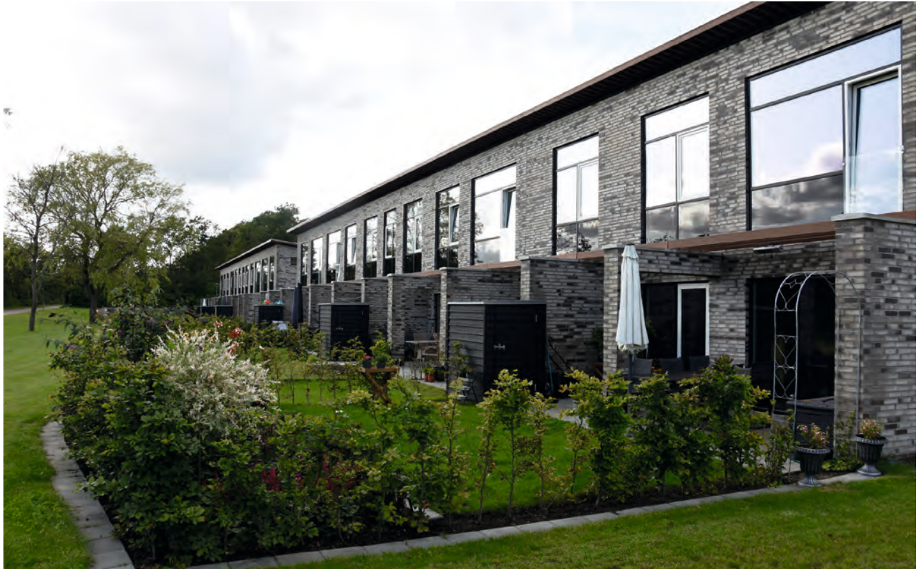
FIGUR 26. Frueløkkes nye rækkehuse er opført oven på soklerne fra en tidligere boligblok. Bygningskroppen er delt op i to ved at lave en passage i midten.
