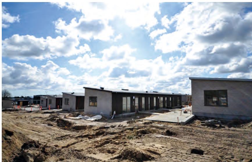
FIGUR 65. Der er skabt omfattende forandringer i bebyggelsen på Ravnkildevej – også topografisk og landskabeligt.
