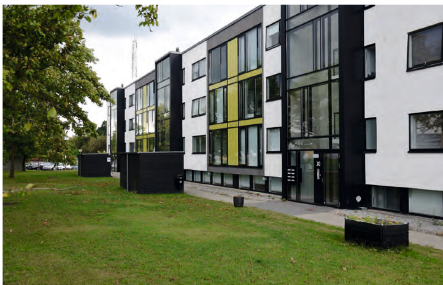
FIGUR 12. Boligsammenlægninger i Hørgården har ført til etablering af 12 familieboliger på 153-159 m 2 . Det har været en fejlinvestering.
