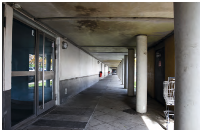
FIGUR 56. Boligblokkenes ankomstforhold har været lavloftede og utrygge. Det er blevet forbedret radikalt – her i Blok 4, hvor fodgænger-dækket i stueetagen er revet ned, og et dobbelthøjt ankomst areal med gennemgang på tværs af boligblokken er blevet etableret.
