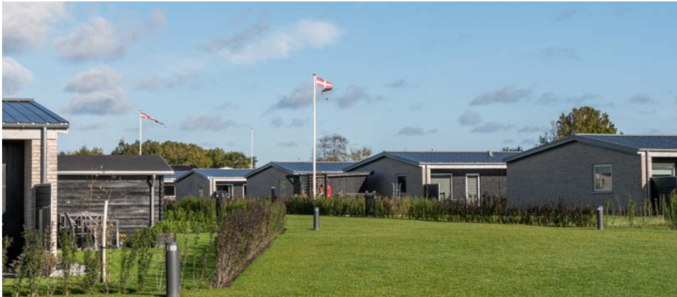
Svenstrup Boligforening, Afdeling 106, Svenstrup Bymidte. Foto: Himmerland Boligforening
