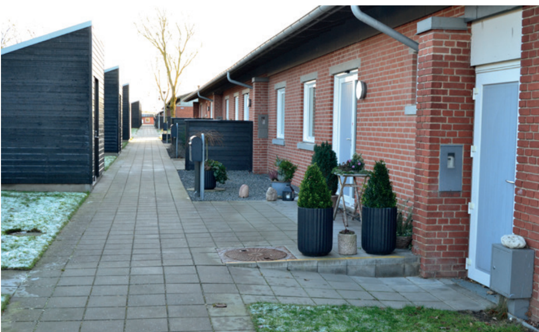
Bomiva Afd. Højlundsvej – efter renovering
