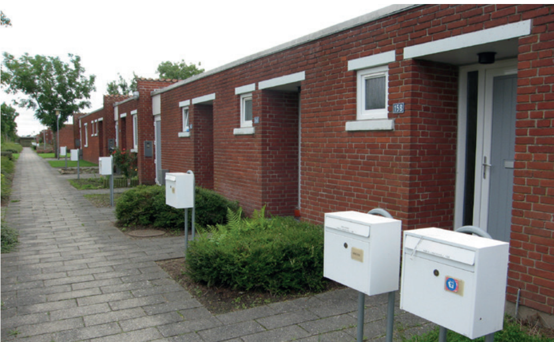
Bomiva Afd. Højlundsvej – før renovering
