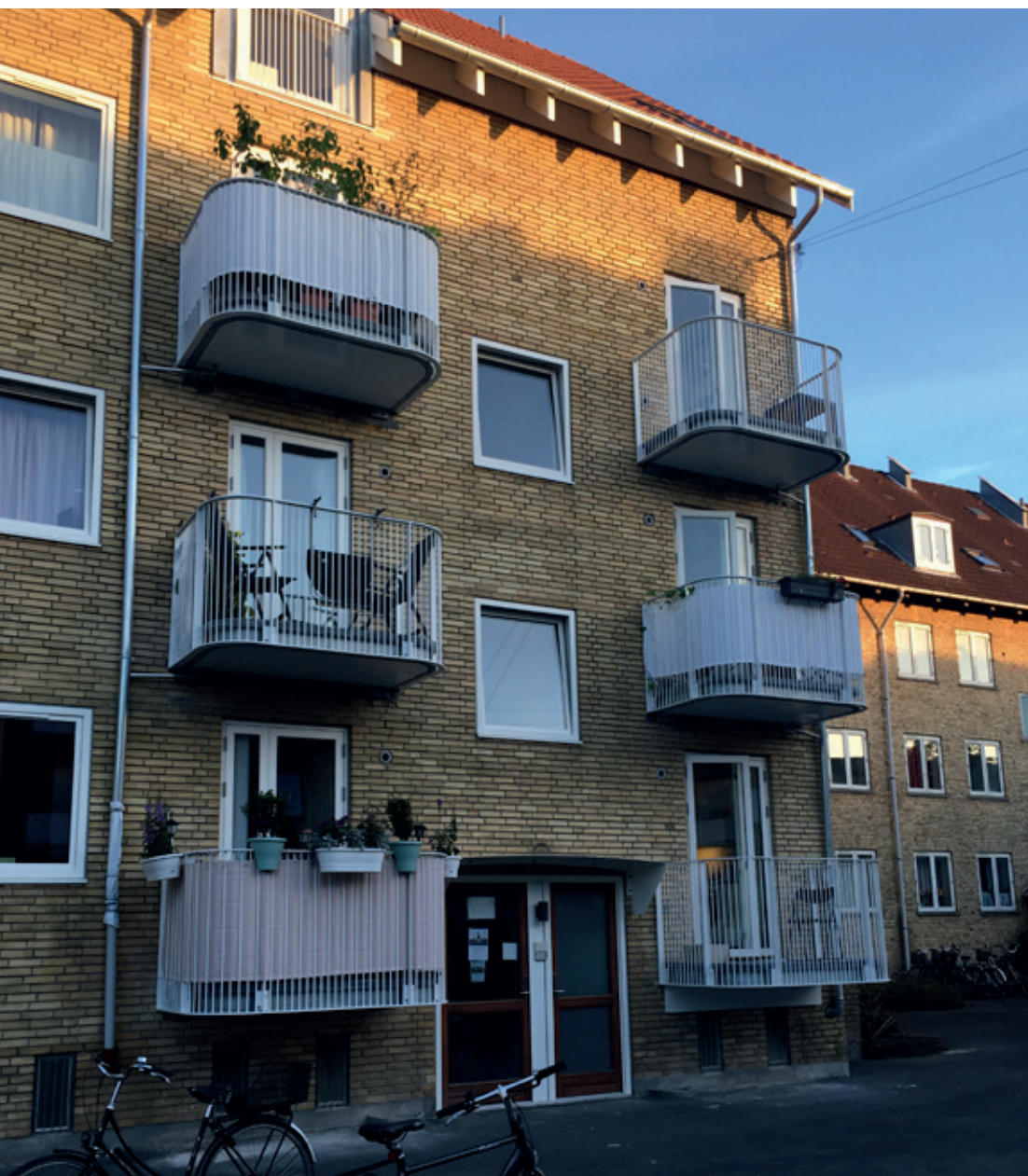
Boligforeningen 3B Afd. Stubmøllevej
