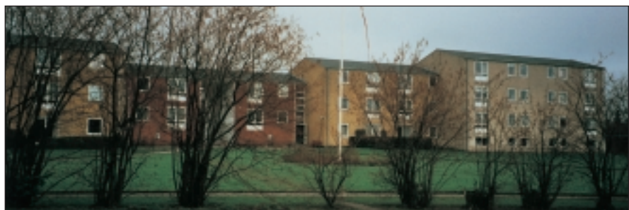
Boligselskabet af 1942 i Middelfart, afdeling 10 og 11. Konsulent var oprindeligt arkitekt Steen Eiler Rasmussen. Afdeling 10 påbegyndte i 2001 nye indbetalinger til fonden. Begge afdelinger står foran større renoveringer. Foto: LBF.
