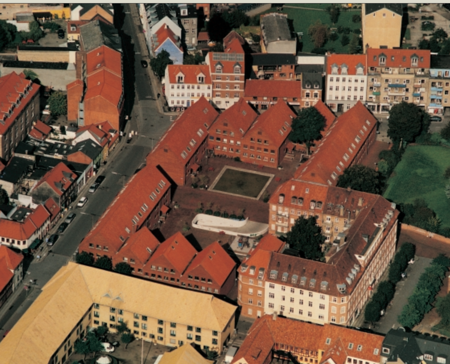
AAB, Århus - afd. 72 Nygade. Byggeriet er indpasset i bydelen som led i en saneringsplan. Der er omfattende skader på konstruktioner i parkeringskælder. Foto: AAB Århus
