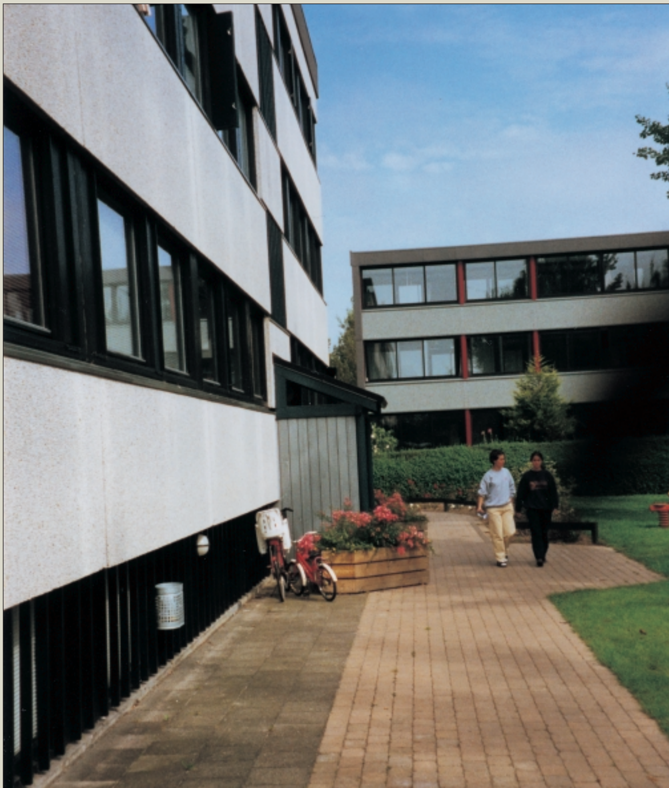
Boligselskabet Danbo, afd. 14 på Havnbjerg, Nordborg. Afdelingen har fået støtte til ombygning og tilpasning af afdelingen. Foto: LBF.
