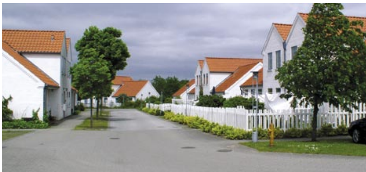
Lejerbo Herning, afd. Munkegårds Allé. Foto: Landsbyggefonden
