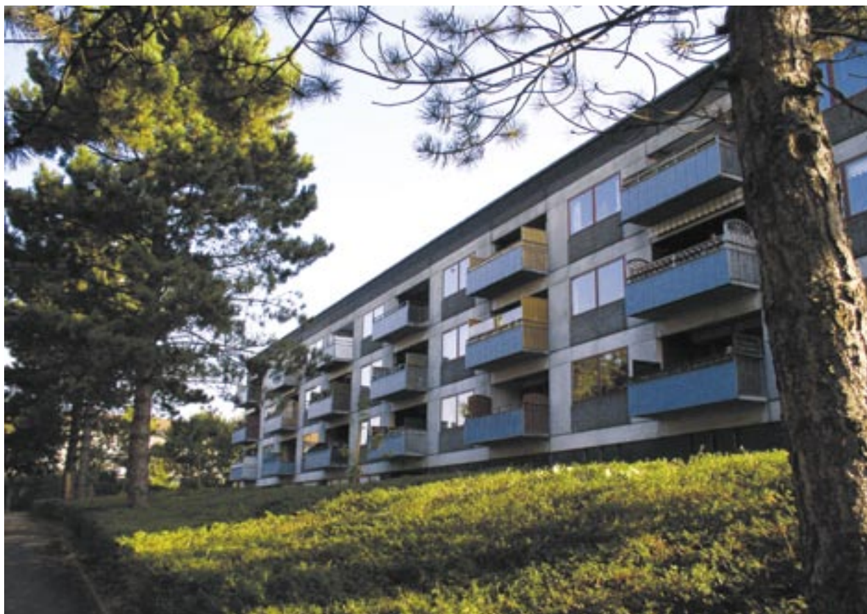
Lejerbo Brøndby, afd. Darup-/Resenlund. Foto: Landsbyggefonden
