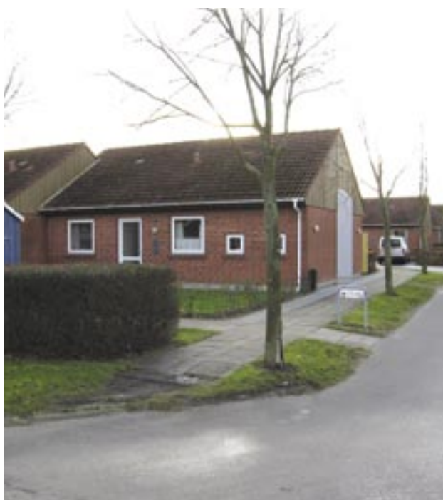
Boligforeningen Lolland, afd. Sandby/Provstelunden. Foto: Landsbyggefonden.
