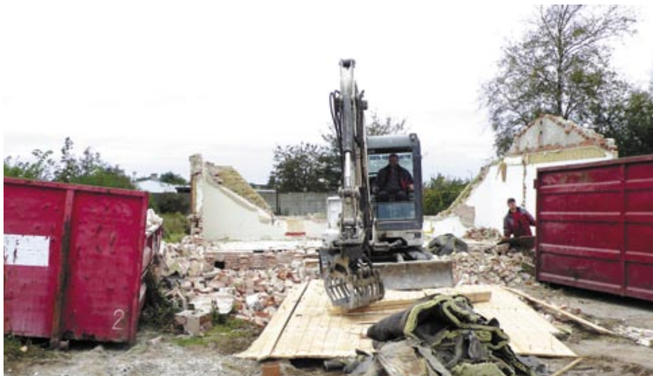
Boligforeningen Vesterport, afd. Fælledbo, Frederikshavn. Foto: Landsbyggefonden
