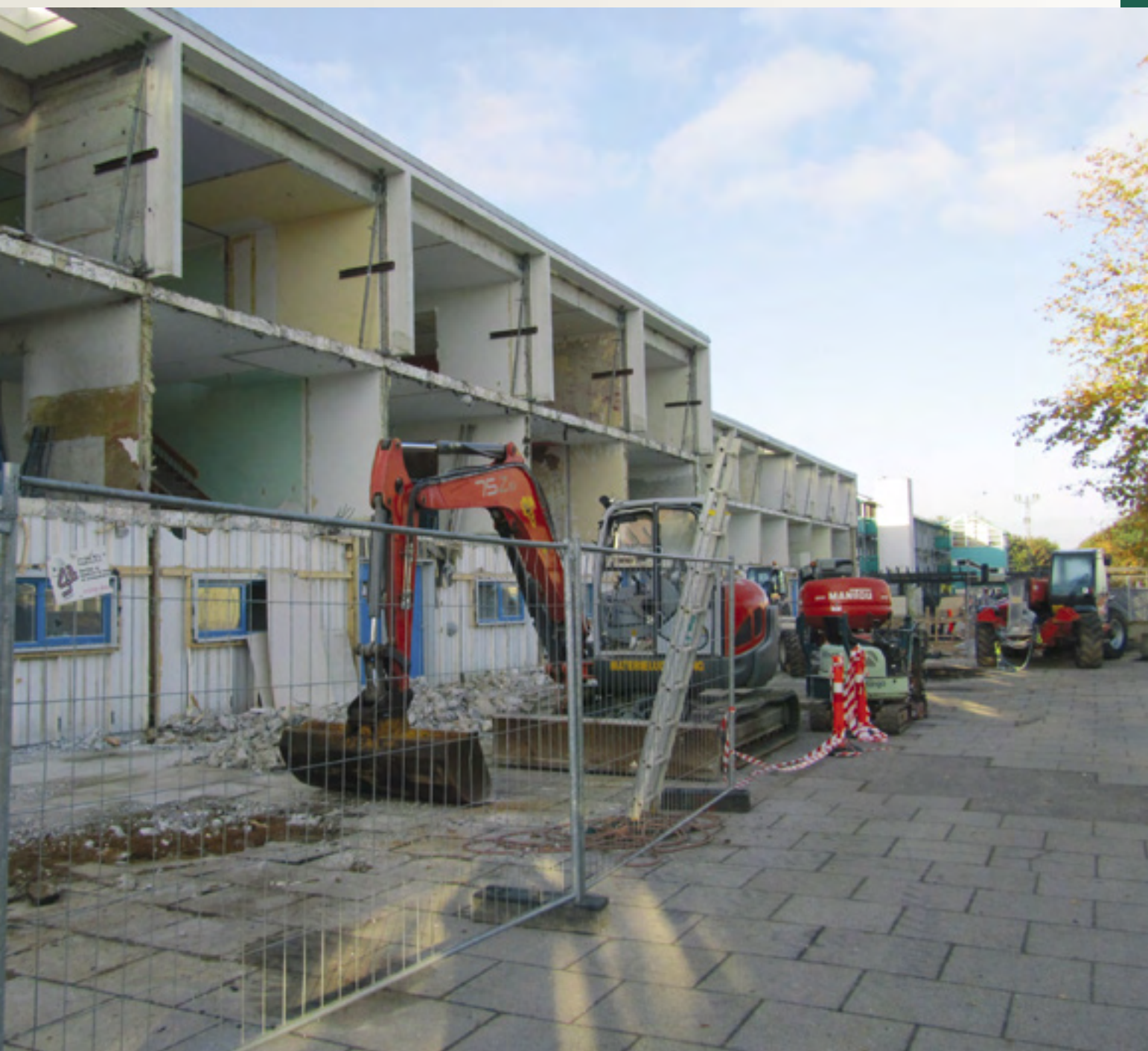
Herning Andelsboligforening – afd. 040, Hedebyen Foto: Landsbyggefonden
