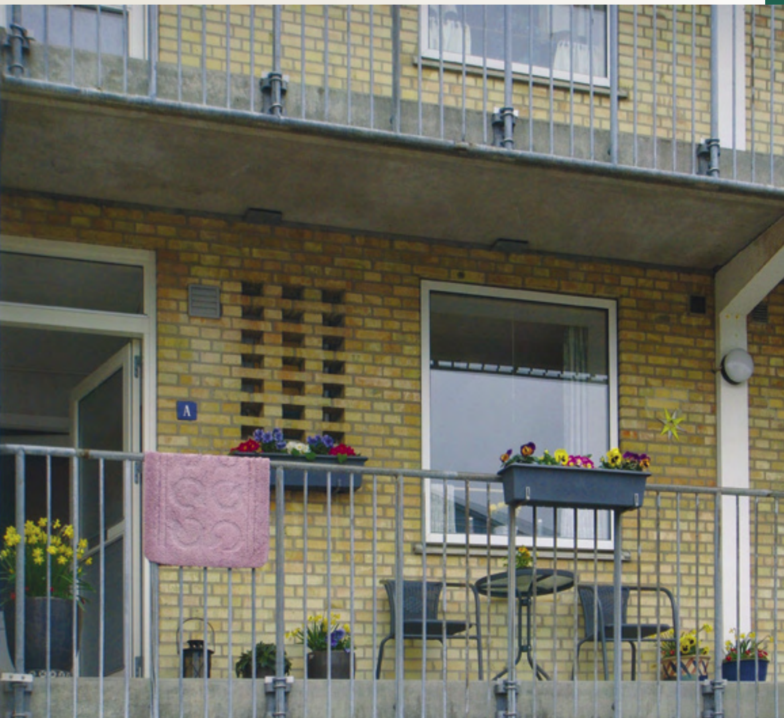
Haderslev Andelsboligforening – afd. 20, Kløervej Foto: Landsbyggefonden
