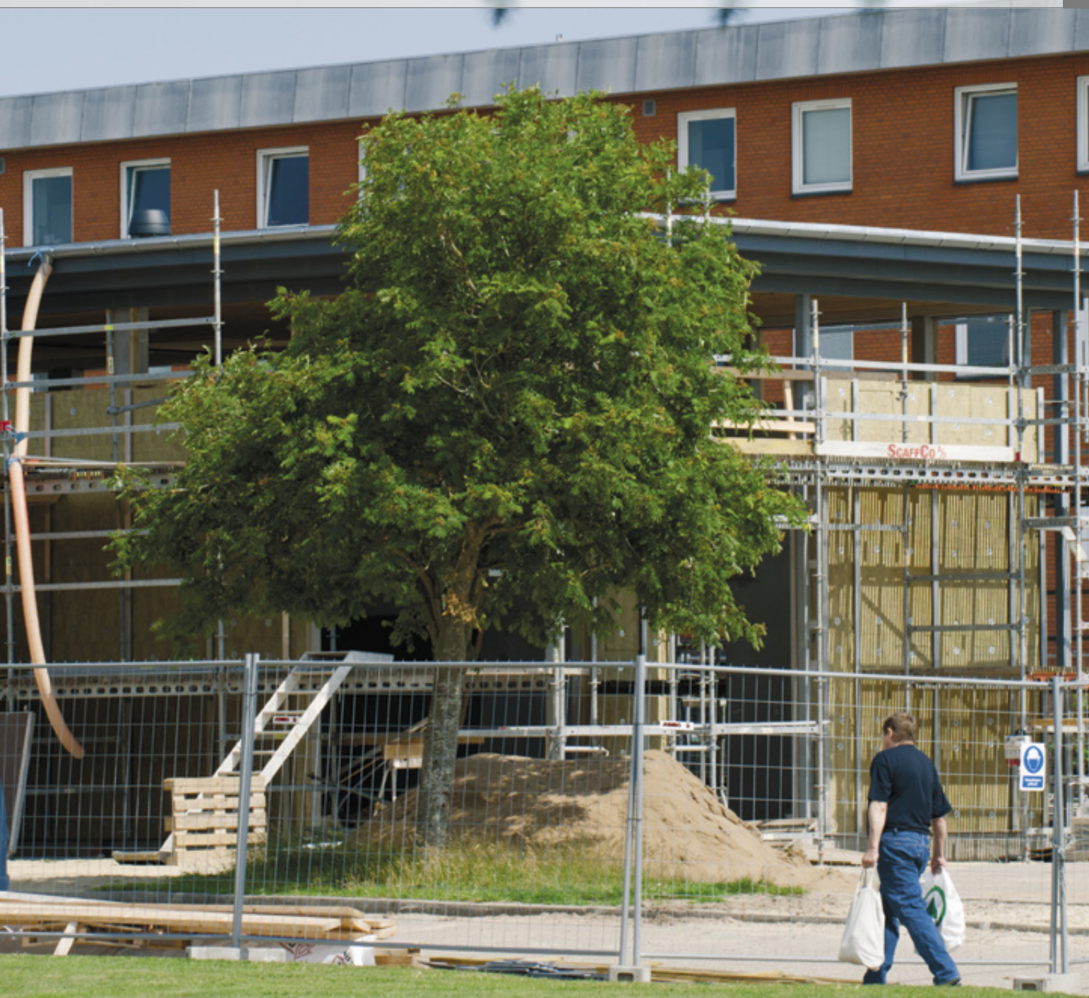
Boligforeningen P.M. – afdeling 11, Knudsgade/Finsensvej Foto: Landsbyggefonden
