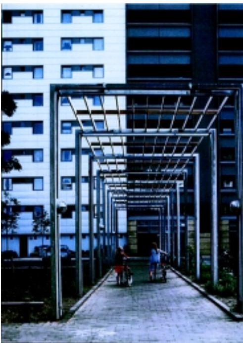
Foto fra hovedstiforløbet, gennembyrningen af de store blokke samt nordøstfacaden.
