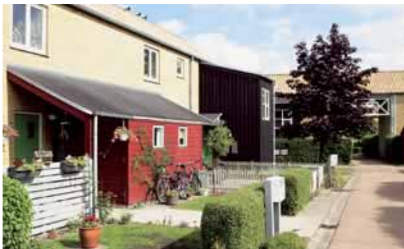
Håndværkerparken er attraktiv, men er plaget af byggeskader.
