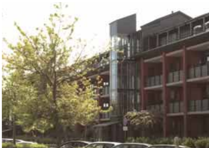
Ny elevator, Irlandsvej
