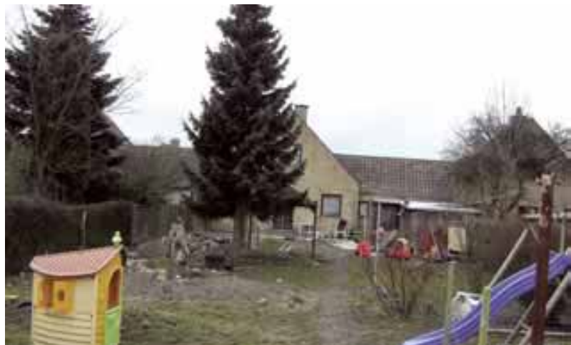
De private haver er nedslidte.
