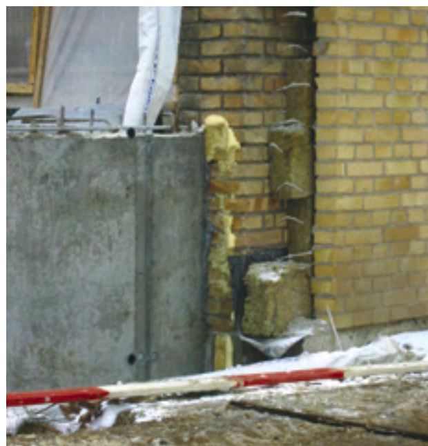
Ny skalmur Foto: Landsbyggefonden
