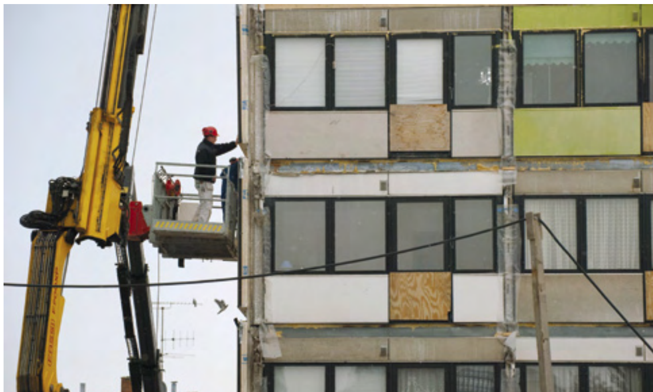
Facaderenovering med kran Foto: Jørgen Jørgensen
